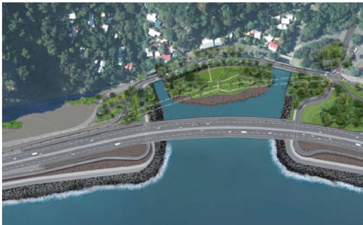
Chantier route du littoral La Réunion
